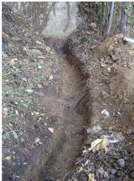
Vista N-S de la rasa amb alguns serveis que la creuen transversalment.
