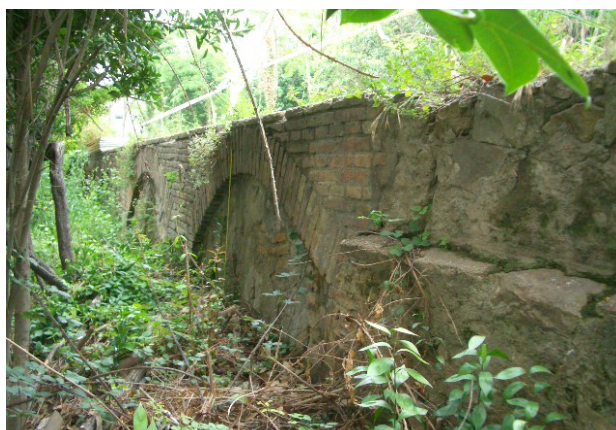
Vista N-S des del talús NE de la carretera del punt de connexió del mur modern amb el mur antic
