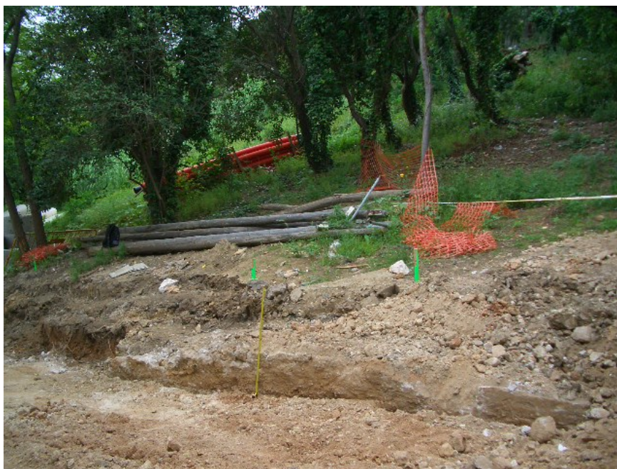
Vista N-S del mur en la banda SO de la carretera
