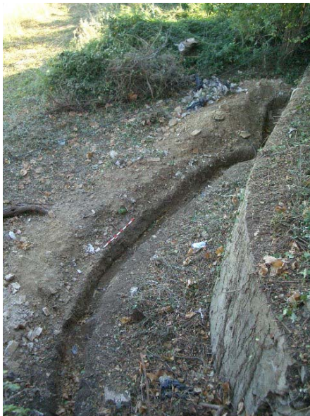
Vista de la rasa des del talús superior, amb el mur de formigó a la dreta.
