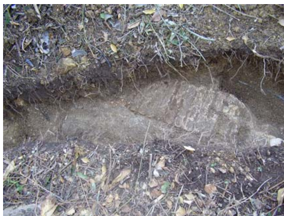
Detall de l'estructura contemporània de maó i ciment
