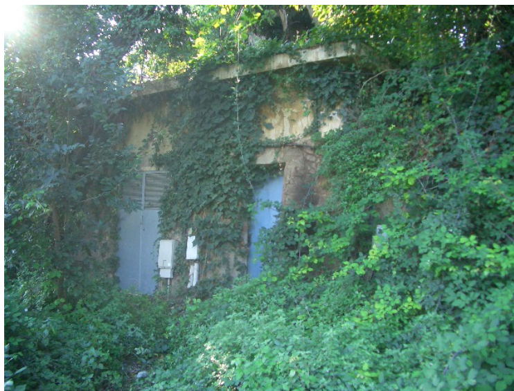
Vista O-E de la caseta de FECSA, abans del desbrossament.
