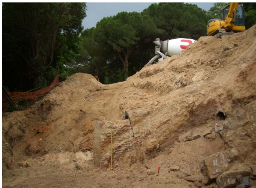
Vista NO-SE del rebaix, amb antics serveis
