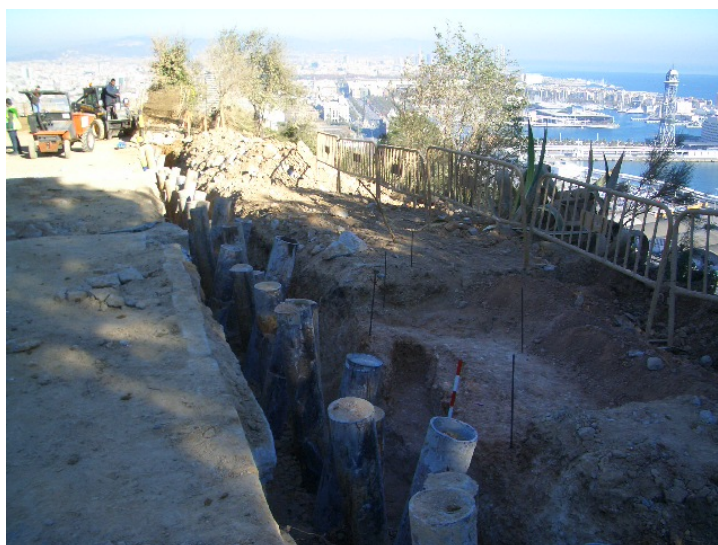
Vista O-E de la situació de la fossa en el perfil de la muntanya, a uns 1'5 m de l'inici del talús.
