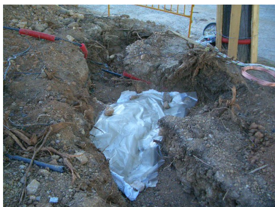
-A baix: vista de la protecció amb geotèxtil i plàstic
