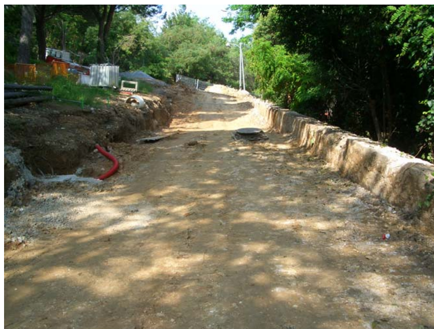
Vista SE-NO del mur sense la fase posterior que el cobria
